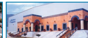
Planta de Manufactura Plásticos Flambeau Moldeo por inyección / soplado - 165,000 pies cuadrados Sattilo, Coahuila, México
