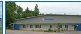
Planta de Manufactura Flambeau Baraboo - Soplado Moldeo por soplado - 228,546 pies cuadrados Baraboo, Wisconsin, USA
